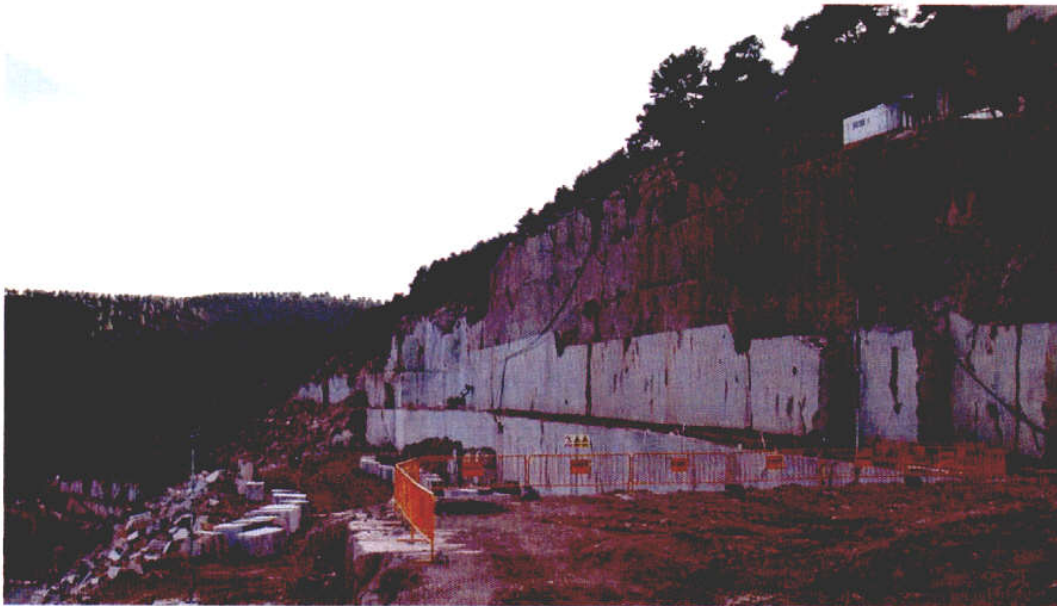
Foto 1.12.- Vista de una de las canteras situada en la Sierra de Burete en la que se observan grandes cortes en busca de las coloraciones más apreciadas. Propiedad del Grupo San Marino.
