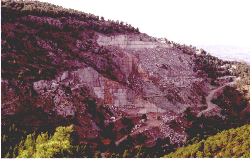
Foto 1.14.- Vista general de las canteras de la zona más al N de la Sierra de Burete. Se observan las diferentes explotaciones a diferentes alturas de la Fm. Burete. En esta visual no se ve ninguna cantera en la Fm. Amm. Rosso Superior.
